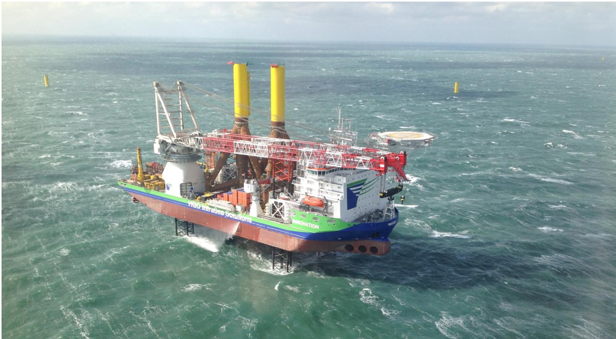
Errichterschiff „Innovation“ von Hochtief bei der Installation der Tripod-Fundamente
