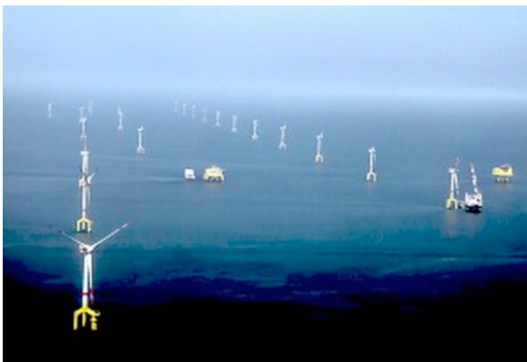
Ende Juli 2013 ist die Errichtungsphase des Windparks BARD Offshore 1 abgeschlossen: 80 Windenergieanlagen mit einer Nennleistung von jeweils 5 Megawatt sind einen Monat vor Planungsziel fertig geworden / Pressebild: BARD
