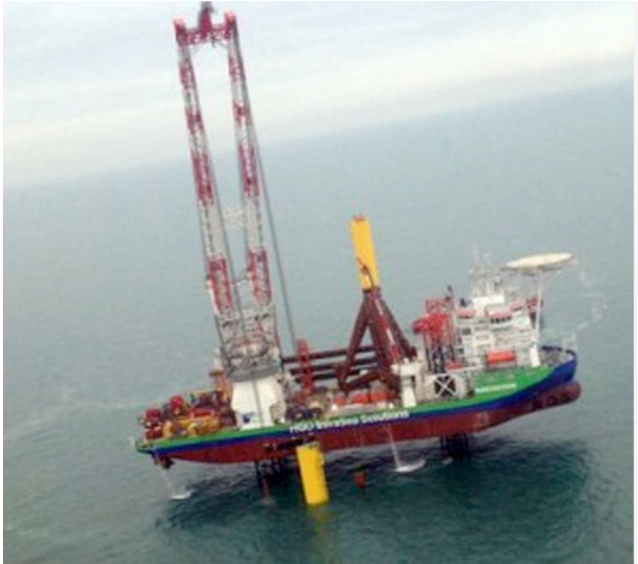
Baufeld-Global-Tech-I / Pressebild: Windreich
